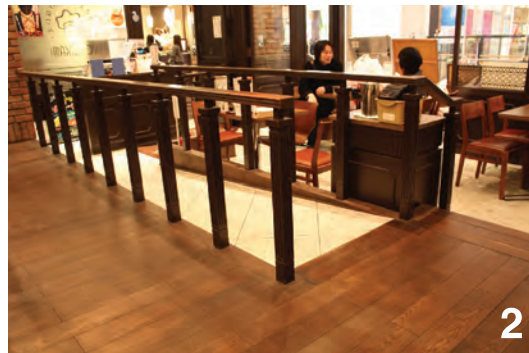
テナントとして入っている洋食店内に設けられた傾斜路
